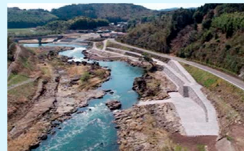
菱刈出張所管内環境整備工事
