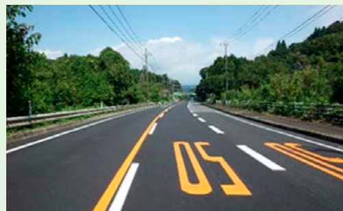
国道10号国分上之段地区舗装修繕工事
