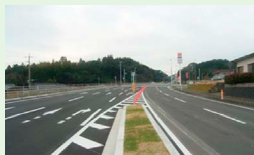
鹿児島3号 隈之城地区舗装工事
