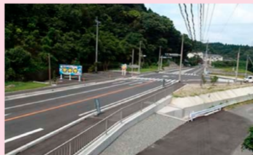
鹿児島3号土橋入口交差点整備工事
