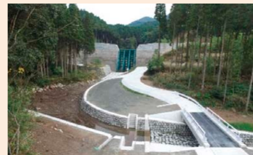
火山砂防工事(大馬越川(3)工区)
