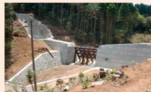
火山砂防工事(黒武者川工区)
