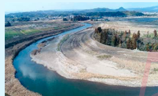
羽月川下流掘削工事
