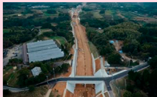
鹿児島3号赤瀬川地区改良工事
