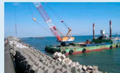
国道226号前之浜地区外防災工事
