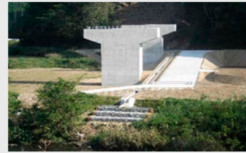
道路改築工事(広瀬道路 26-3)
