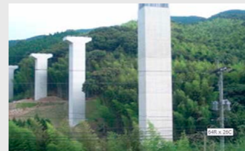
道路改築工事(泊野道路 18-2)
