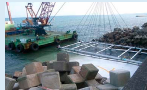
国道226号前之浜地区外防災工事
